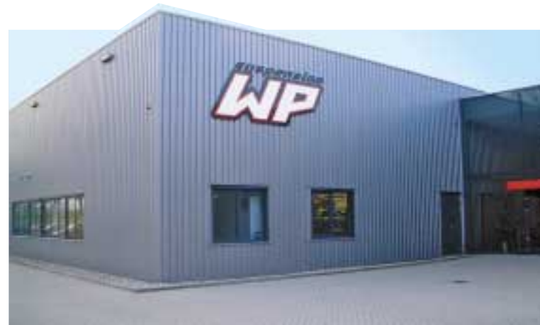
Hinter diesen Wänden liegt das Zentrum niederländischer Fahrwerkstechnik. Hier in Malden, 30 Kilometer von der Grenze zu Deutschland entfernt, sind Entwicklung, Prototypen-Bau, Serienproduktion und der Spezialbereich Rennsport auf 7500 Quadratmetern unter einem Dach zusammengefasst.
