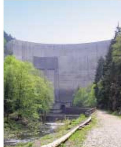
Die Staumauer der Okertalsperre erhebt sich 75 Meter in die Höhe.
